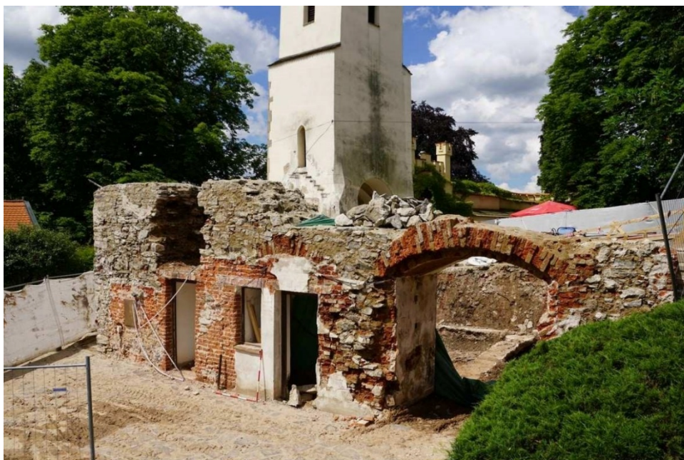
Obr. 2 – pohled na východní zeď bývalého hradního pivovaru tvořenou kamenným zdivem hradby; stav po zastavení bouracích prací a probíhajícím záchranném archeologickém výzkumu v květnu/červnu 2020 ( předběžná archeologická zpráva )
