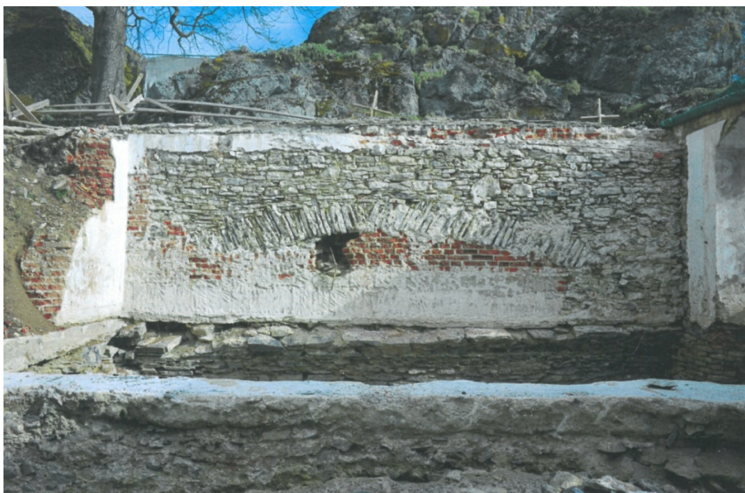
Obr. 4 – odhalený líc příčné kamenné severní zdi s vylehčovacím pasem, pod níž se nachází rozkrytá sklepní prostora s relikty valené kamenné klenby (projektová dokumentace)
